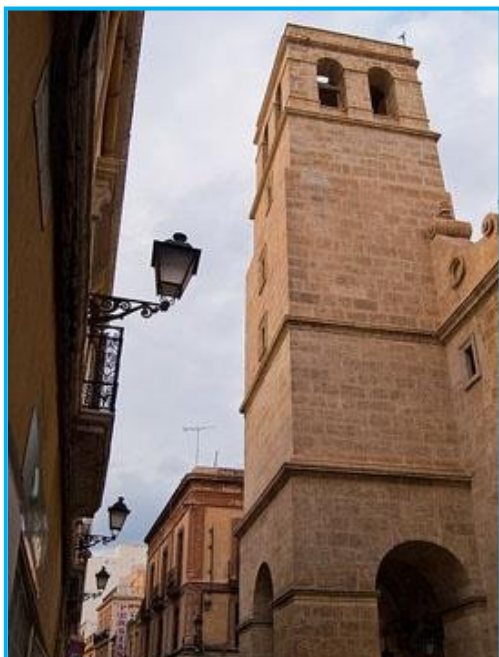
Fachada Iglesia Santiago en Almería
